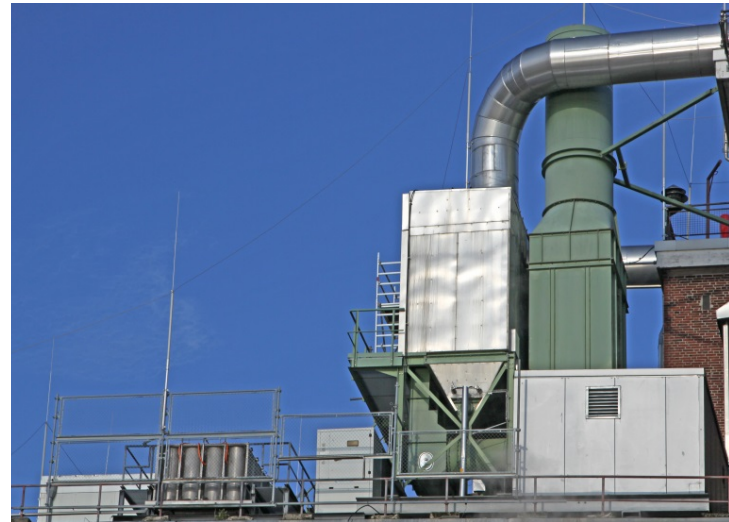
Bild 2: In der Heißgasfiltration vermeidet die Rückgewinnung der thermischen Energie nach dem Filtrationsprozess nicht nur energieintensives Wiederaufheizen des Abgases, sondern trägt auch zum Schutz nachgelagerter Aggregate bei.
