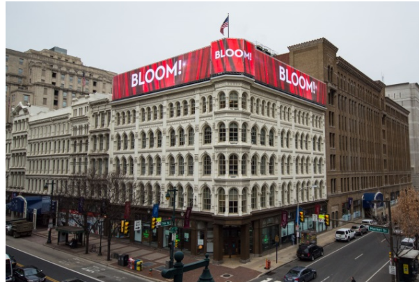
Bild 2: Das MEDIAMESH®-System der GKD aus Edelstahlgewebe mit integrierten LED-zeilen zeichnet sich durch seinen besonders niedrigen Stromverbrauch aus und lässt sich am Ende seiner Lebenszeit nach vielen Jahrzehnten zu 100 Prozent recyceln.
