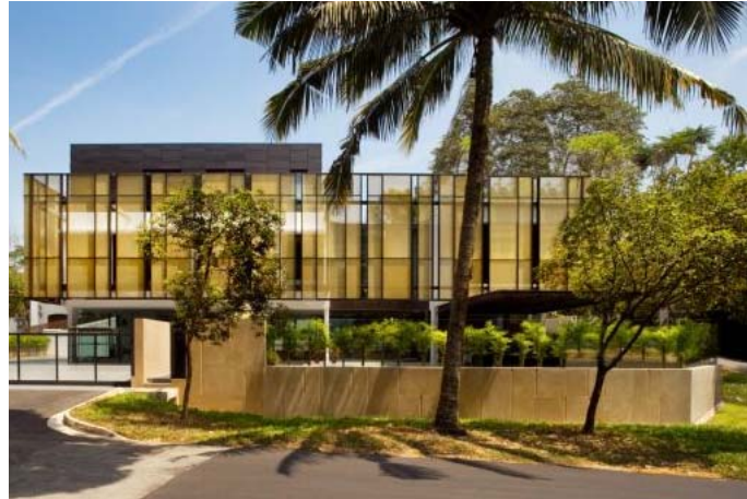
Bild 6: PC-Gewebe von GKD verbinden edle Optik mit Pflegeleichtigkeit, Korrosions-, Witterungs- und UV-Beständigkeit, hier als farbig eloxierte Fassadenverkleidung vom Typ PC-Alu 6010.
