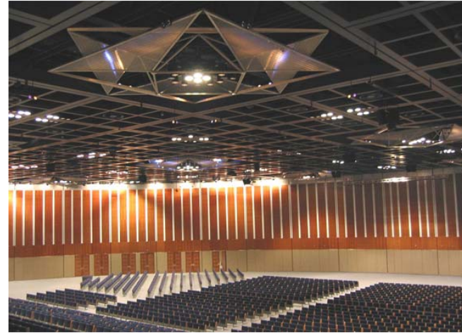
Bild 2, Jewel Box aus Tigris Gewebe an der Decke des Dubai Convention Centre Picture 2, Jewel Boxes of tigris mesh at the ceiling of the Dubai Convention Centre
