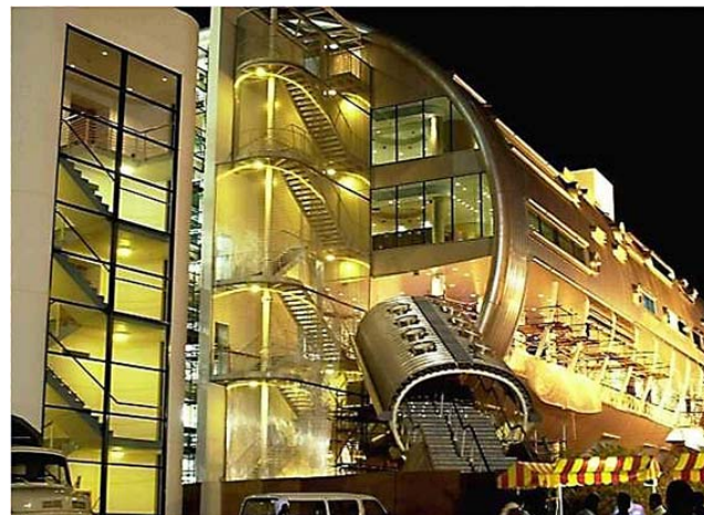
Bild 4, Treppenhausverkleidung an der Kamelrennbahn Nad Al Sheba Picture 4, staircase cladding of the grandstand at the Nad Al Sheba camel race track
