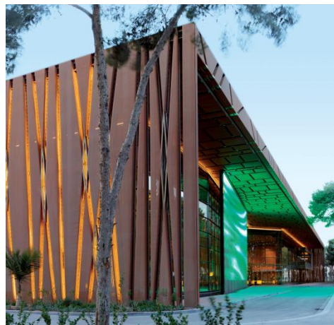
Bild 15: Für die Hülle des Tripoli Convention Center in Libyen wurde Edelstahlgewebe vom Typ Kiwi in einem Bronzefarbtönen lackiert.
