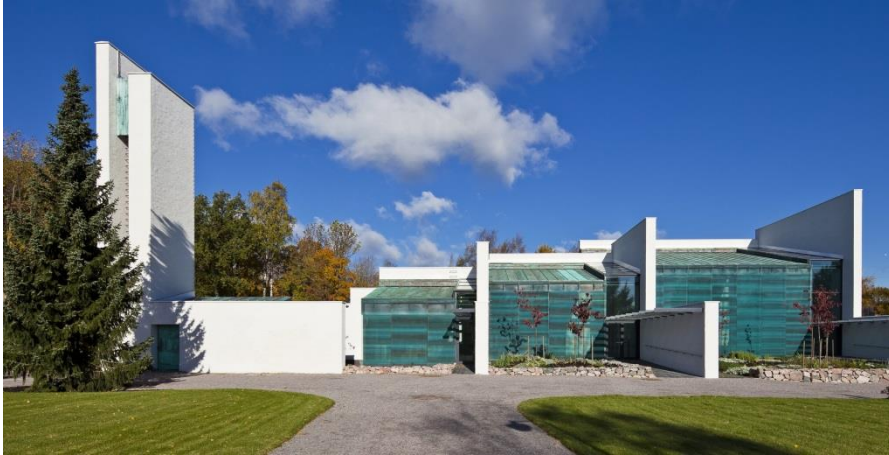
Bild 6: Grün patiniertes Bronzegewebe vom Typ Baltic verkleidet die Chapel of St. Lawrence in Vantaa, Finnland.
