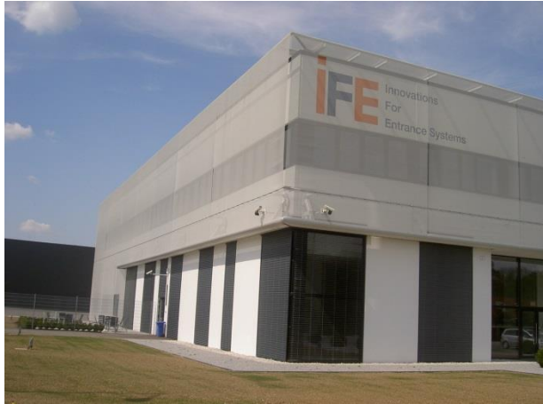
Bild 12: Edelstahlgewebe vom Typ Omega 1520 mit weiß lackiertem Schussdraht umhüllt den oberen Teil der Fassade des Technologiecentrums Kematen/Ybbs in Österreich.
