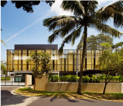
Bild 8: Ein Privathaus in Singapur – die Golden Box – wird von einem goldfarbenen eloxiertem Gewebe vom Typ Alu 6010 umhüllt.
