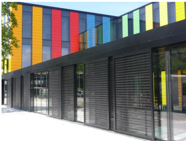
Bild 14: Schwarz lackiertes Edelstahlgewebe vom Typ Escal 7x1 verkleidet die Cafeteria der École Polytechnique Fédérale (EPFL) in Lausanne.
