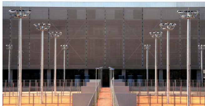
Bild 6: Das Erscheinungsbild der olympischen Tennishalle Caja Mágica wird durch ihre semitransparente Metallgewebefassade von GKD geprägt.
