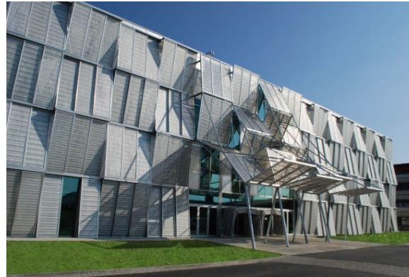
Bild 7: Seine Einzigartigkeit verdankt der Pôle de bio-ingénierie der Ecole Polytechnique Fédérale de Lausanne (EPFL) einer dreidimensionalen Zickzack-Fassade aus 630 horizontal verschiebbaren Sonnenschutzelementen aus Metallgewebe von GKD.
