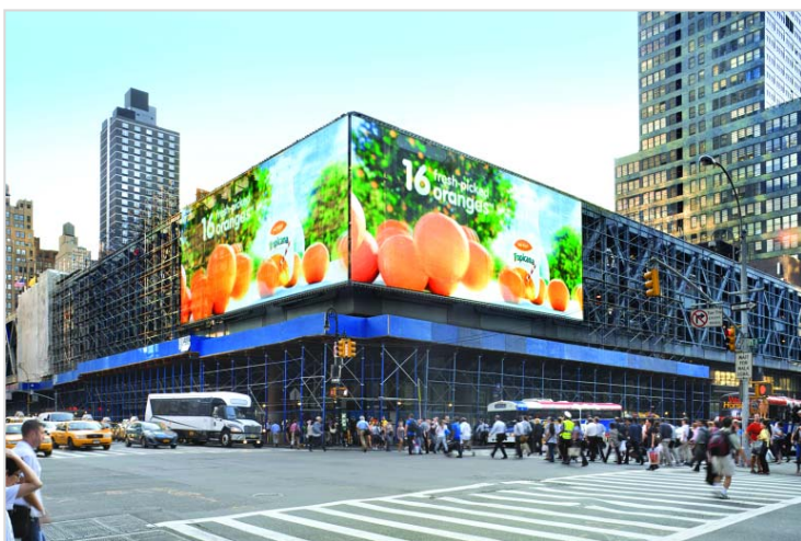
Bild 4: Mediamesh® -Medienfassade mit 5 LEDs/Pixel am Port Authority Bus Terminal in New York.
