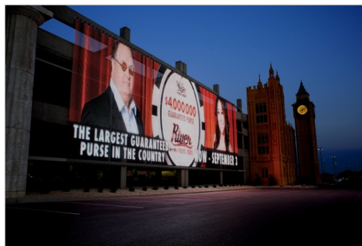
Bild 5: Transparente Mediamesh® -Fassade mit 6 LEDs/Pixel von GKD am Winstar World Casino in Thackerville, Oklahoma.
