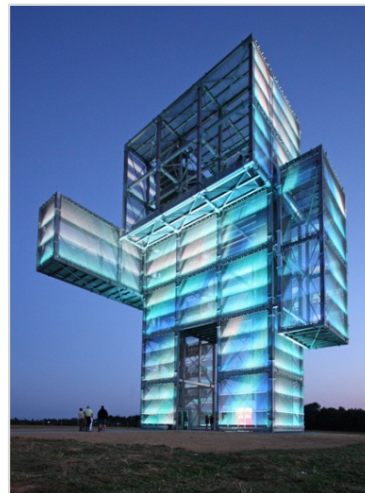
Bild 9: Eine Haut aus Illumesh® -Gewebe lässt den Indemann in bunten Farben erstrahlen.
