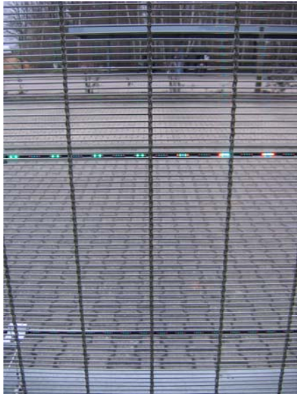
Bild 7: Prototyp bei GKD: Transparente Fassade ILLUMESH®
