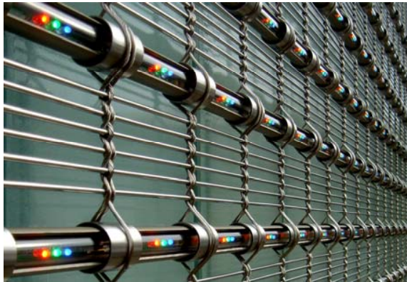
Bild 1-3: MEDIAMESH® ermöglicht durch eingewebte LED-Profile, Metallgewebe mit elektronischen Bildern via Internet zu bespielen.
