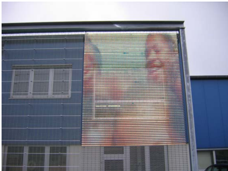
Bild 10: Prototyp bei GKD: Live-Bespielung auf transparenter Fassade MEDIAMESH®
