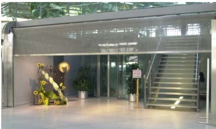
Bild 3: Das stabile Rolltorsystem aus Metallgewebe verhindert trotz seiner filigranen Anmutung unerwünschten Zutritt und Diebstahl.
