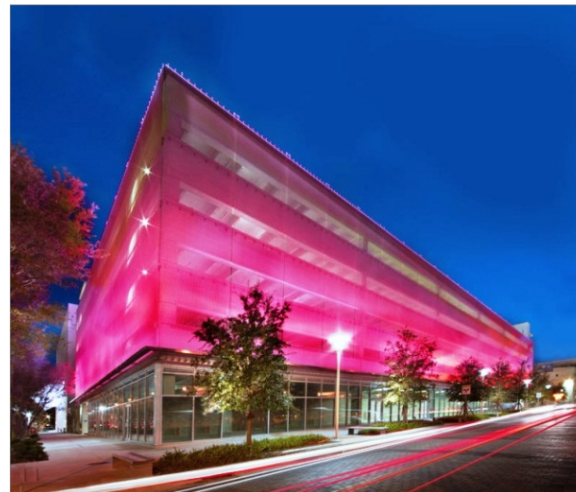
Bild 3–4: Die fast 2.500 m 2 große Fassade wird von insgesamt 49 Paneelen aus gewebtem Edelstahl vom Typ Helix 12 umhüllt und per LED-Licht farbig illuminiert.
