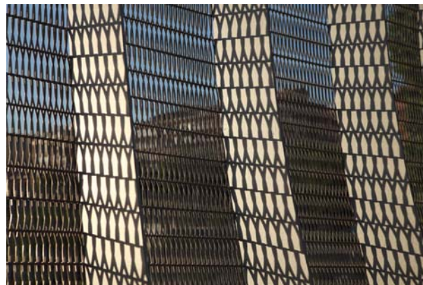
Bild 5-6: Das Gewebeband gewährleistet eine natürliche Beleuchtung und Belüftung der Brücke und bietet zugleich Schutz vor der Sonne.
