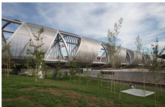
Bild 3: Edelstahlgewebe vom Typ Escalé umschlingt die Brücke auf voller Länge und verwandelt sie in eine schimmernde Helix.
