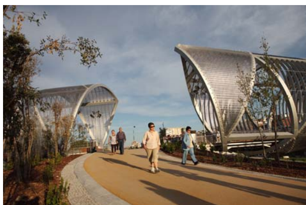
Bild 7: Die beiden spiralförmig ummantelten Brückenteile ragen weit in den Park hinein und treffen sich in ihrer Mitte auf einer Plattform.
