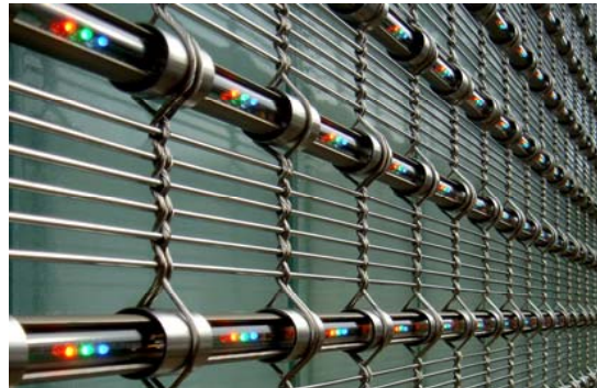
Bild 4 (links): MEDIAMESH® ermöglicht durch eingewebte LED-Profile, Metallgewebe mit elektronischen Bildern via Internet zu bespielen.
