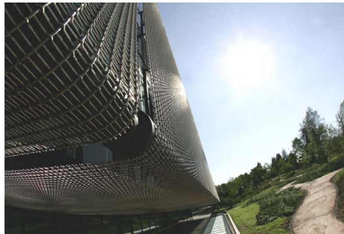
Bild 2: Das GKD-Gewebe vom Typ Omega 1847 aus Edelstahl und eloxiertem Aluminium wurde schräg vor die Glasfassade gespannt und oben und unten jeweils um 90 Grad umgelenkt.
