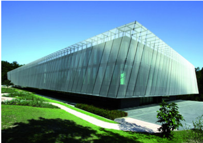
Bild 1: Als weithin sichtbares Symbol für das Netz eines Fußballtores erhielt The Home of FIFA eine filigrane Edelstahlgewebehaut.
