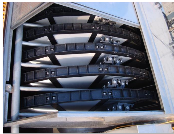
Bild 5: Eingebaute OT 10µm Filterelemente von GKD.
