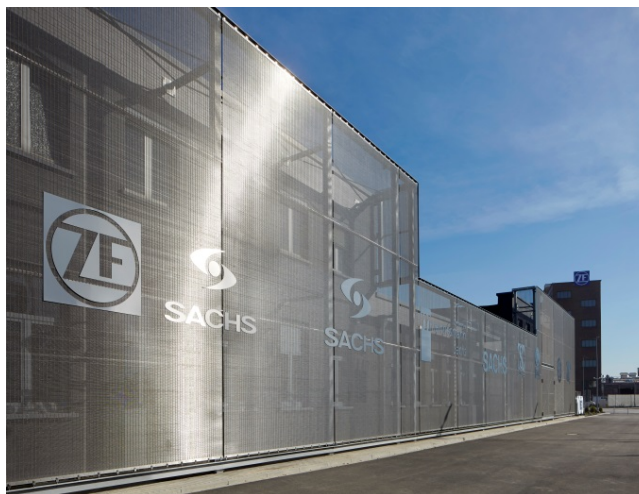
Bild 7: Der stylische Showroom der ZF Friedrichshafen AG in Schweinfurt wird von einer schimmernden Haut aus Metallgewebe der GKD vollflächig umhüllt.
