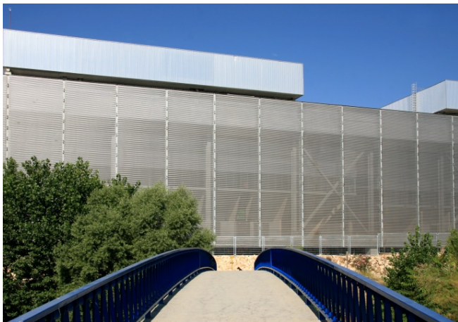
Bild 9: Das GKD-Spiralgewebe vom Typ Escale 7 x 1 am Tennis Center Madrid, in Spanien, dient als Absturzsicherung, ist wartungsfrei, robust und hat eine nahezu unbegrenzte Lebensdauer.
