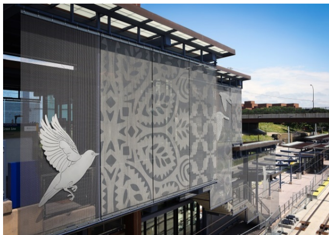
Bild 1: Zum Schutz gegen die Sonne wurde der Bahnhof der West Bank Station in Saint Paul, USA, mit Edelstahlgewebe vom Typ Omega der GKD verkleidet. Etching und applizierte Edelstahlvögel verwandeln die Fassade zu einem Kunstwerk.
