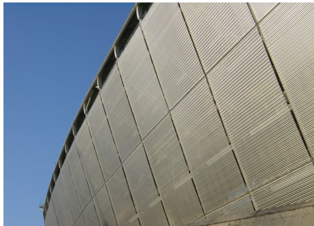
Bild 6: Das am Estadio Santiago Bernabéu, in Madrid, Spanien, eingesetzte Edelstahlgewebe vom Typ Escale 7 x 1 der GKD verbindet durch seine Flächigkeit Dynamik mit einer geradezu verblüffenden dreidimensionalen Anmutung.
