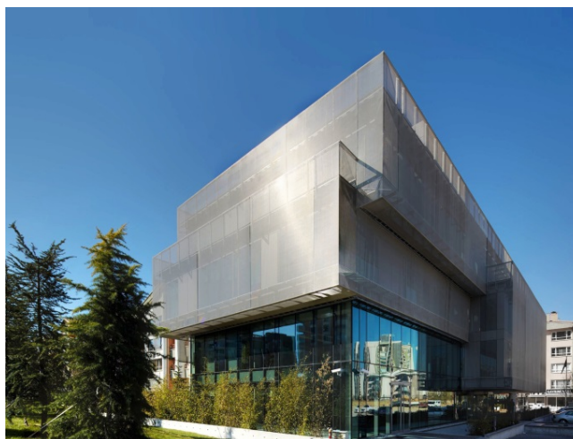
Bild 3: Die Sonnenschutzfassade aus Edelstahlgewebe vom Typ Omega 1520 der GKD leistet einen maßgeblichen Beitrag zum nachhaltigen Gebäudekonzept des neuen Headquartars des Türkischen Bauunternehmerverbands in Ankara, Türkei.
