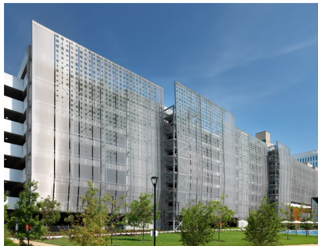
Bild 4: Bis zu 27 Meter hohe und drei Meter breite Bahnen aus bedrucktem Edelstahlgewebe vom Typ Omega 1520 der GKD verhüllen die offenen Parkdecks des Samsung Headquartars in San José, USA.
