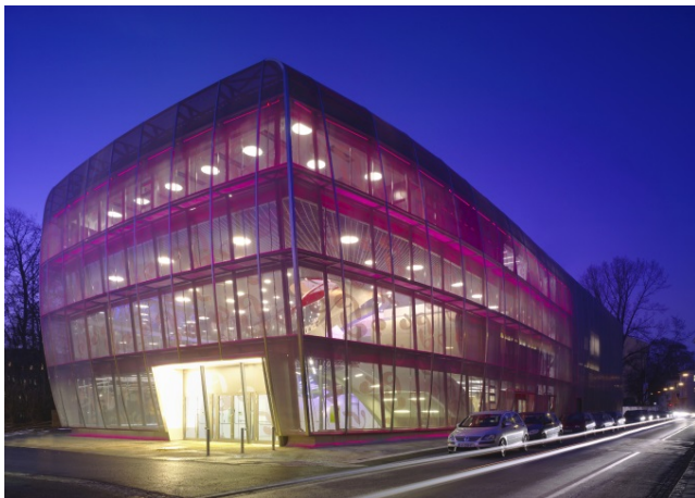
Bild 5: 66 Bahnen des Edelstahlgewebes vom Typ Omega der GKD bilden die 4.000 Quadratmeter große transluzente Hülle des Hauses für Musik und Musiktheater (MUMUTH) in Graz.
