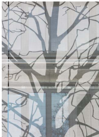
Bild 1-2: Beispielhaft für das Siebdruckverfahren steht ein Ärztehaus in Freiburg, dessen Gewebefassade von GKD mit einem Waldmotiv bedruckt wurde.
