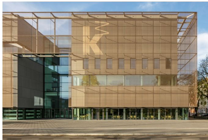
Bild 3: Das GKD-Sondergewebe an der Fassade der Kunsthalle Mannheim erhielt seinen markanten Bronzeton durch mit Speziallack in Durchlaufverfahren beschichtete Drähte.
