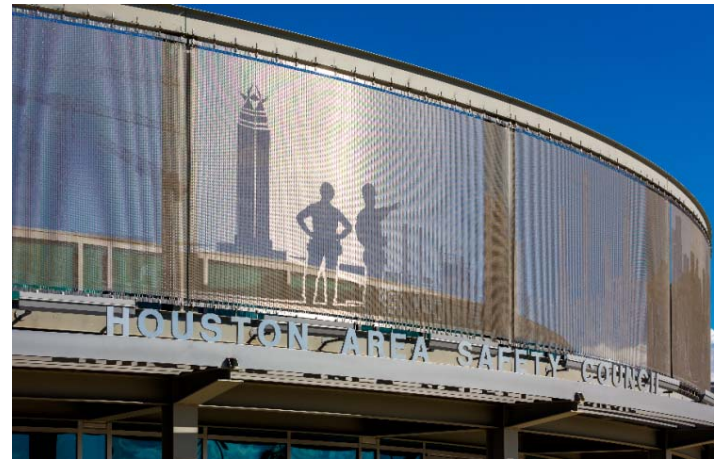
Bild 12: Die runde Dachbrüstung des Houston Area Safety Council (HASC) aus semitransparentem Edelstahlgewebe vom Typ OMEGA 1510 gestaltete GKD durch eine besonders aufwendige Form von Etching.
