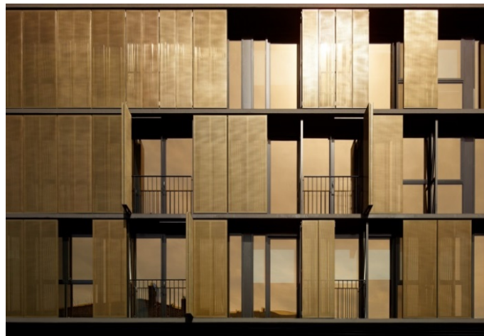
Bild 5: Die bronzen glänzende Sonnenschutzfassade aus dem eloxierten Aluminiumgewebe ALU 6010 von GKD verleiht den Luna Apartments in St. Kilda, Melbourne, ihr unverwechselbares Aussehen.
