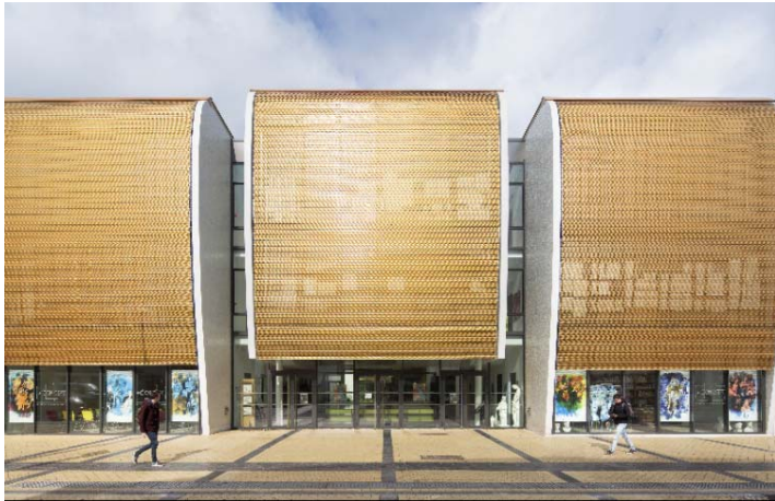
Bild 6: Beispielhaft für Sonnenschutzlösungen aus farbig eloxiertem Aluminiumgewebe von GKD sind die goldenen, gebäudehohen Bogenfassaden aus Spiralgewebe an der École d'Art de Calais.
