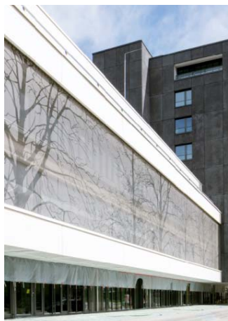
Bild 1-2: Beispielhaft für das Siebdruckverfahren steht ein Ärztehaus in Freiburg, dessen Gewebefassade von GKD mit einem Waldmotiv bedruckt wurde.
