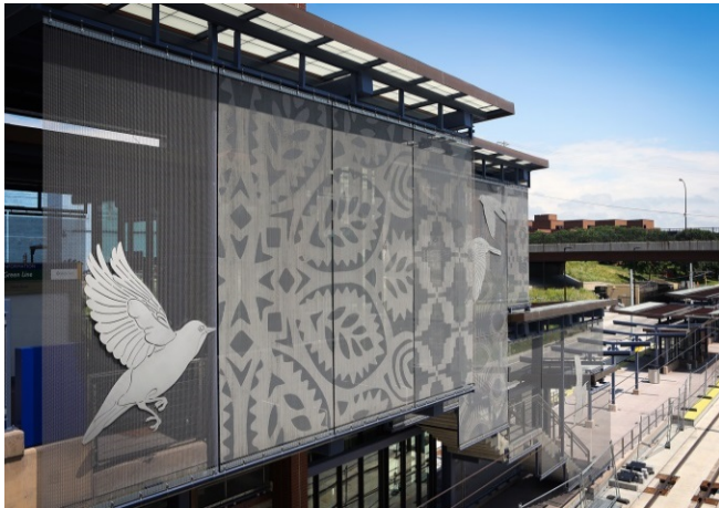
Bild 11: Durch Etching überträgt GKD grafische Elemente auf Metallgewebe und schafft so aufmerksamsstarke Fassaden wie hier an der West Bank Station in Minnesota.
