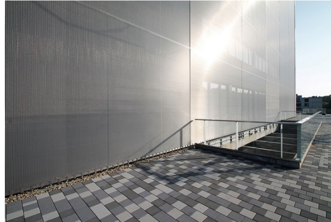
Bild 2: Die Edelstahlhülle von GKD dient als Sonnenschutz, der die Oberflächentemperatur der Fassade reduziert.
