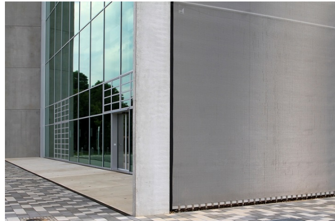
Bild 5: Die seitlichen Fassaden werden von einer schimmernden Haut aus Metallgewebe überspannt, die eine optisch nahtlose Flächigkeit erzeugt.
