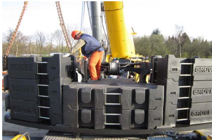
Bild 6: Die von der Jebens GmbH gefertigte Grundplatte schultert bis zu 120 Tonnen Gewicht aus zwölf Graugussplatten.
