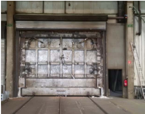
Bild 1: In dem 15 Meter langen, 5,8 Meter breiten und 3,8 Meter hohen Glühhofen werden bei Jebens im Werk Nördlingen Großbauteile mit Stückgewichten von bis zu 160 Tonnen optimal auf ihren weiteren Einsatz vorbereitet.
