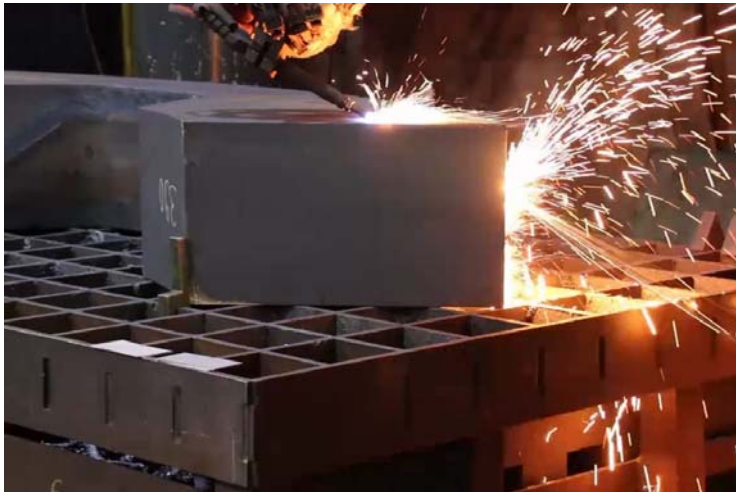
Bild 5: Jebens brachte in der bogenförmigen Bauteilkontur sechs Fasen in unterschiedlichen Ebenen nach Zeichnung an.
