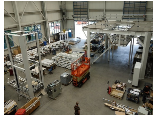
Bild 12: Eine Extruderbühne im Bau
