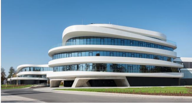
Bild 1: Inspiriert von der wellenförmigen Bewegung der Wellpappe entstand das Life Cycle Building , ein lichtdurchfluteter, runder Gebäudekomplex.
