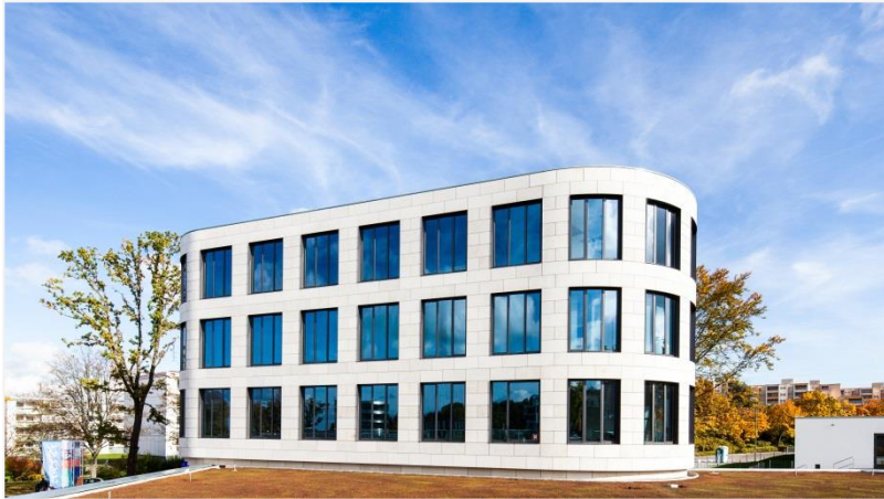
Bild 1: Der Pforzheimer Architekt Jochen Abraham entwarf die Volksbankfiliale Tiergarten als monolithischen Stahlbetonbau.
