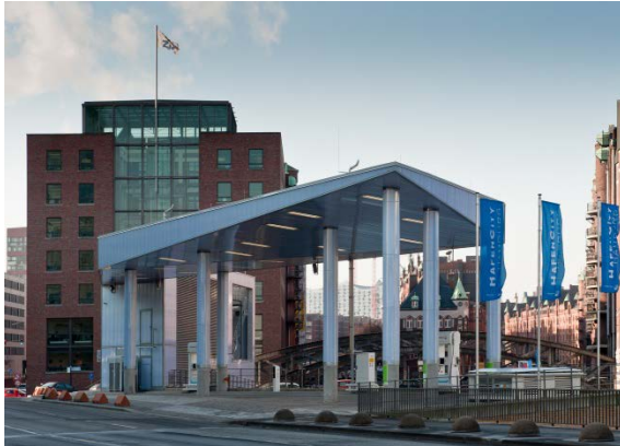
Bild 9: Täglich 20 Linienbusse und zusätzlich weitere PKW werden an dieser Tankstelle in Hamburg mit Wasserstoff versorgt.
