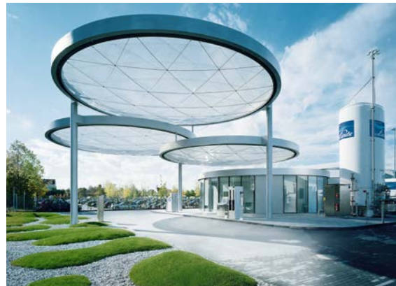
Bild 8: Zeitgemäßer Einsatz von Edelstahl Rostfrei beim Linde Hydrogen Center, der modernsten deutschen Wasserstofftankstelle in Deutschland.
