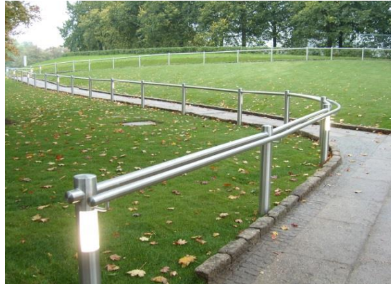
Bild 7: Geländer aus nichtrostendem Stahl sorgen für eine attraktive, nutzerorientierte Flächentrennung.
