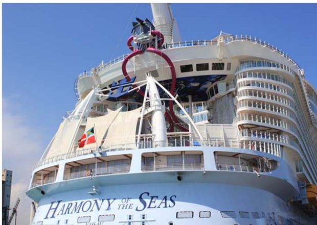
Bild 7: Hightech-Gigant: Die Harmony of the Seas verfügt über ein Ver- und Entsorgungssystem aus über 80 Kilometer Edelstahl-Rohrleitungen der Güte 1.4401.
