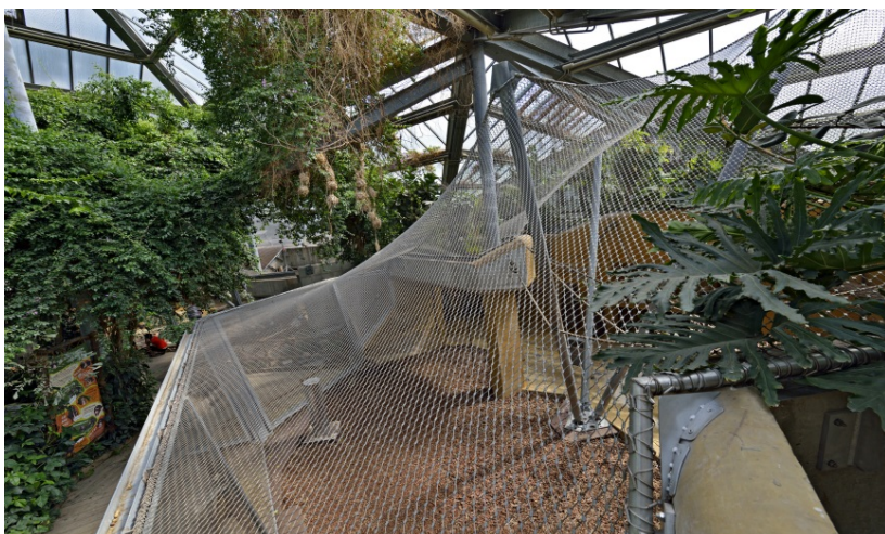
Bild 8: In Tiergärten kommen Netzkonstruktionen aus Edelstahl immer häufiger als raumschaffende Alternative zu massiven Gittereinzäunungen zum Einsatz.
