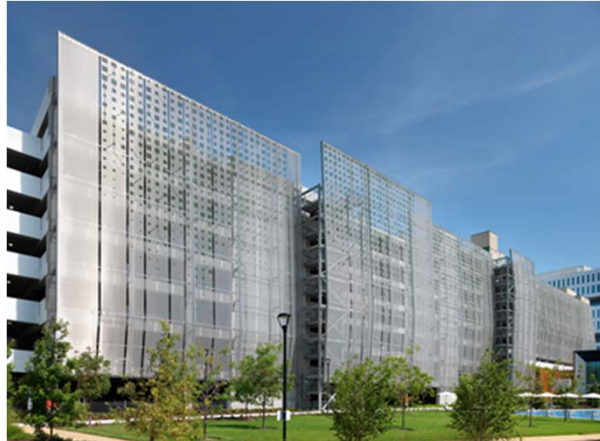
Bild 6: Das Samsung Headquarter in San José, USA, setzt zur optischen Integration des Parkhauses in den Firmencampus auf bedrucktes Edstahlgewebe.
