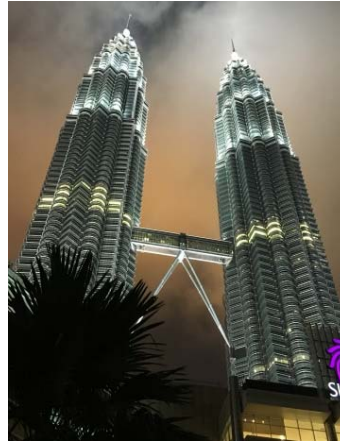
Bild 2: Die Petronas Tower in Kuala Lumpur setzen mit ihrer hochglänzenden Haut aus nichtrostendem Stahl ein eindrucksvolles Zeichen.
