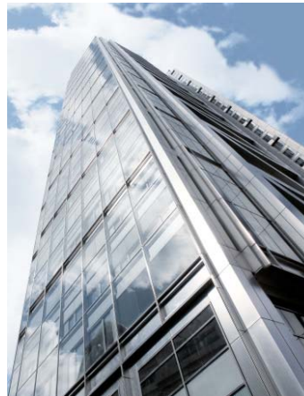
Bild 4: 11.606 Quadratmeter Bleche aus nichtrostendem Stahl gestalten fachwerkartig die Seiten des 242 Meter hohen Heron Towers in London.
