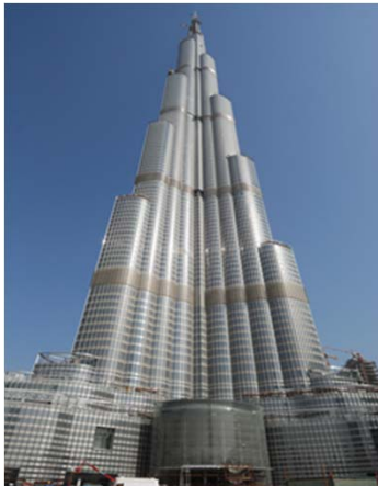
Bild 3: Schutz vor Korrosion: Zur Gestaltung des Burj Khalifa in Dubai wählten die Planer Edelstahl Rostfrei mit Qualitätssiegel als Fassadenbaustoff.
