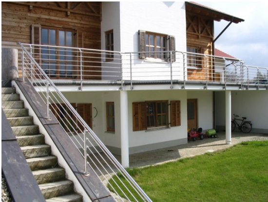
Bild 3: Horizontal montierte Füllstäbe aus Edelstahl Rostfrei erzielen eine puristische Anmutung.
