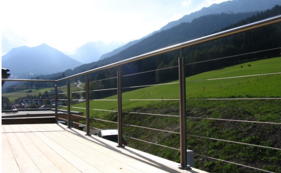
Bild 1: Pfosten aus Flachstahl, Vierkant- oder Rundrohr mit Seilfüllung aus Edelstahl Rostfrei überzeugen durch optische Leichtigkeit.
