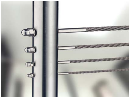
Bild 7+8: Eine professionelle Montage von Balkonbrüstungen und -verkleidungen setzt voraus, dass ausschließlich Verbindungselemente wie Schrauben und Unterlegscheiben aus Edelstahl Rostfrei verwendet werden.
