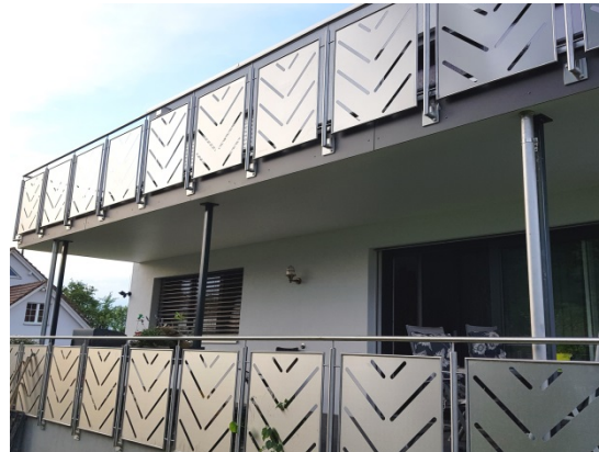
Bild 6: Gekantete Kassetten aus Edelstahl Rostfrei, die per Laser zugeschnitten werden, fügen sich harmonisch in jede Fassadengestaltung ein.
