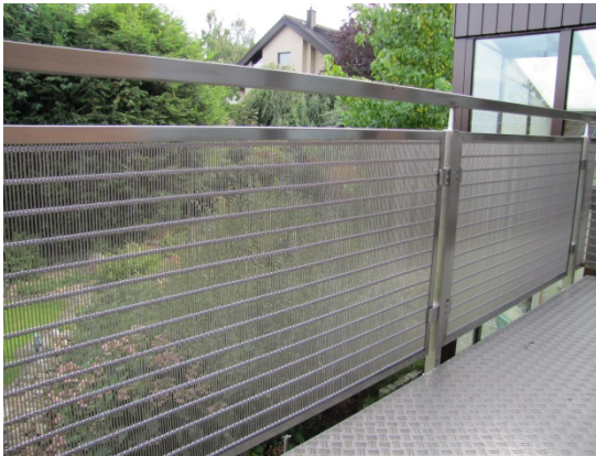
Bild 4: Besonders hochwertig sind filigrane Rahmensysteme mit flächenbündig in dünnen U-Profilen verklebtem Gewebe aus Edelstahl Rostfrei.
