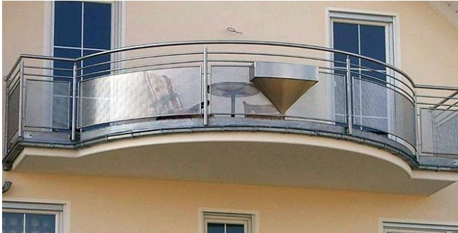
Bild 2: Lochblech aus Edelstahl Rostfrei verbindet nahezu unbegrenzte Transparenz mit Sicherheit.
