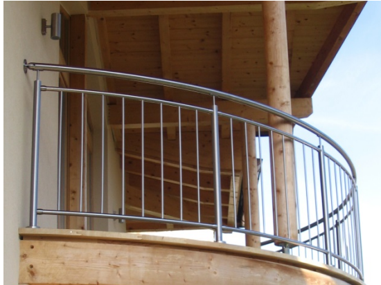
Bild 5: Balkonverkleidungen aus Edelstahl Rostfrei mit vertikal montierten Füllstäben garantieren einen freien Ausblick auf Landschaft und Natur.
