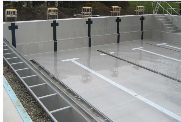
Bild 1-2: Funktionale, optische und wirtschaftliche Lösung: Schwimmbäder erhalten durch eine dauerhaft dichte und korrosionsfeste Wanne aus nichtrostendem Stahl ein neues Gewand.
