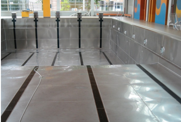
Bild 1-2: Funktionale, optische und wirtschaftliche Lösung: Schwimmbäder erhalten durch eine dauerhaft dichte und korrosionsfeste Wanne aus nichtrostendem Stahl ein neues Gewand.
