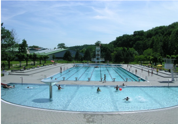
Bild 13: Werkstoffbedingte Frostsicherheit: Die im Freibadbereich gefüllten Becken aus Edelstahl Rostfrei können ohne besonderen Maßnahmen überwintern.
