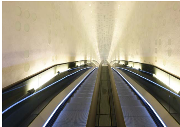
Bild 4: Kein Ende in Sicht: Die Rolltreppe in der Elbphilharmonie in Hamburg wurde als Bogentreppe konzipiert.
