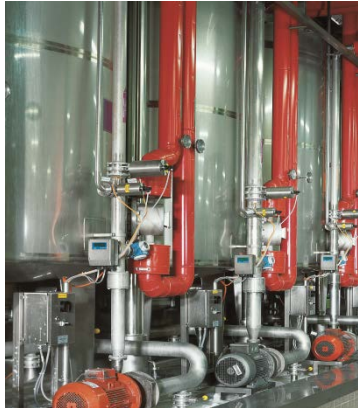
Bild 13-14: CIP (Cleaning-in-Place)-Tanks aus Edelstahl sorgen dafür, dass Hygiene auch in Brauereien das A und O ist.
