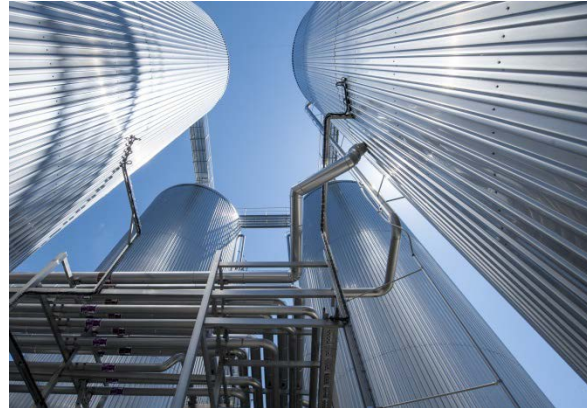
Bild 2: Vor dem Schroten und Einmaischen wird das Malz in großen Edelstahlsilos gelagert.
