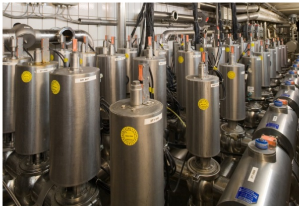
Bild 5: Ventilknoten aus Edelstahl sind nichtrostend, geschmacksneutral sowie säure-, temperatur- und druckbeständig.
