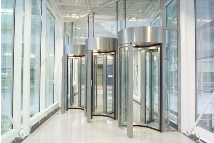
Bild 1: Schon beim Betreten des Terminals lenken Drehtüren aus Glas und Edelstahl die Besucherströme so, dass keine Staus entstehen.
