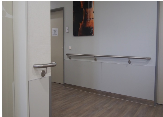
Bild 3+4: Handläufe aus Edelstahl Rostfrei bieten bei sachgerechter Reinigung zuverlässigen Schutz vor Keimablagerungen.
