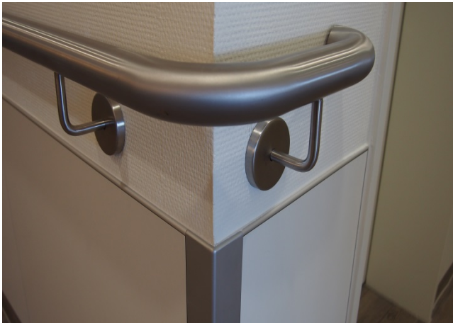
Bild 3+4: Handläufe aus Edelstahl Rostfrei bieten bei sachgerechter Reinigung zuverlässigen Schutz vor Keimablagerungen.
