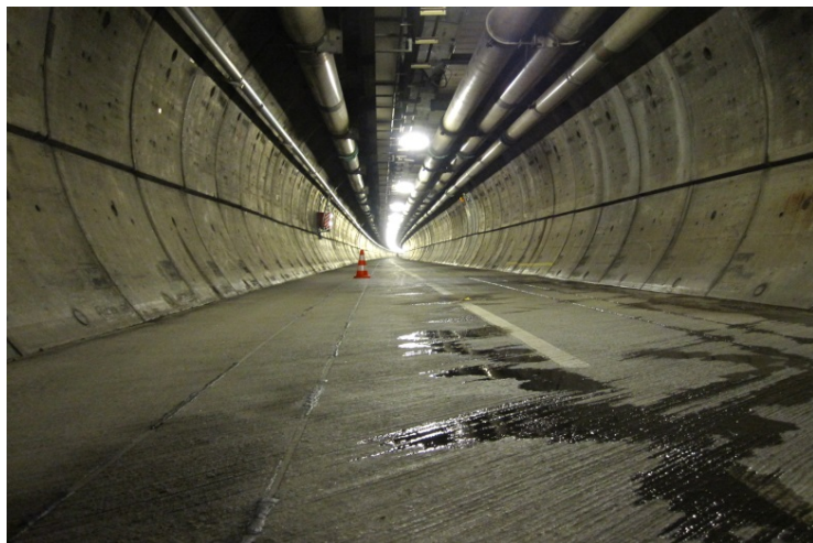
Bild 5: In dem 4,8 Meter breiten Service- und Rettungstunnel im Eurotunnel wurden 4.000 Rohrmeter aus hochfestem Duplex-Stahl für die Hauptleitung verlegt.
