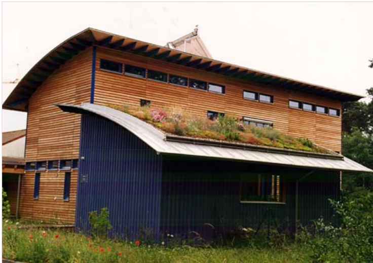
Bild 3: Begrünte Dächer bieten einen effektiven zusätzlichen Lärm- und Schallschutz.
