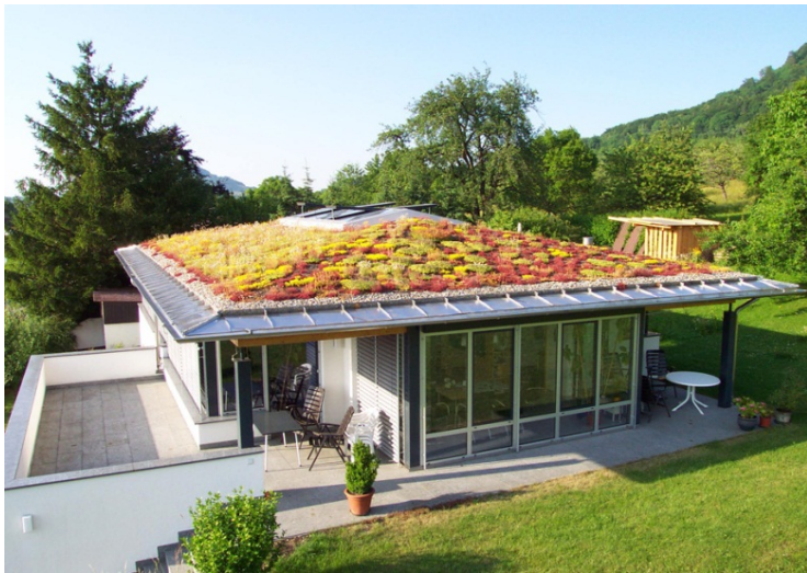
Bild 1: Gründächer mit einer Dachabdeckung aus Edelstahl Rostfrei sehen gut aus und haben zahlreiche ökologische und ökonomische Vorteile.
