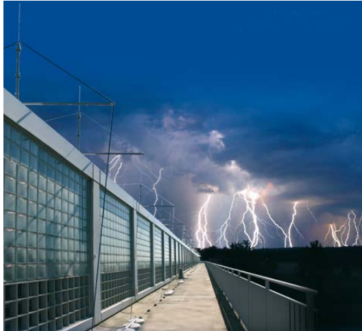
Bild 1: Jährlich entstehen in Deutschland Schäden von mehreren Hundert Millionen Euro durch Blitzschlag.
