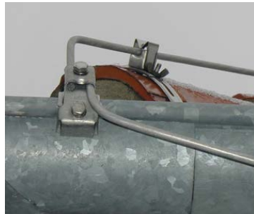
Bild 4: Erdung, Dachrinnenklemme und Leitungshalter für den Dachfirst.
