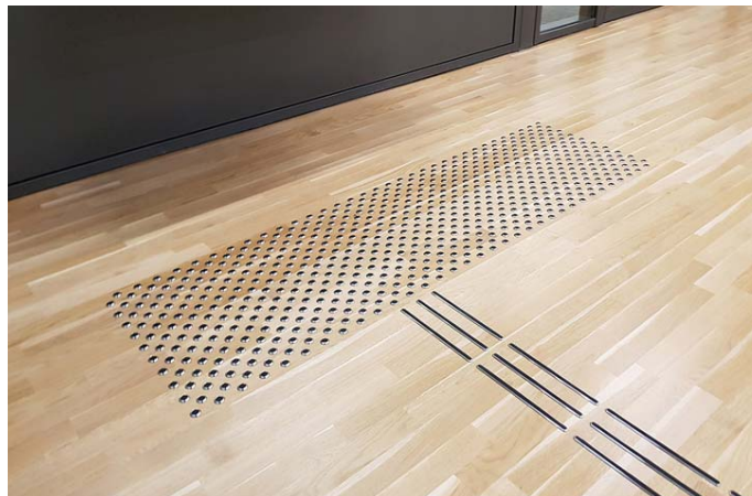
Bild 10: Blinde können Bodenindikatoren mit dem Langstock ertasten und so ohne fremde Hilfe vom Eingang des Gebäudes bis zum gesuchten Ziel gelangen.
