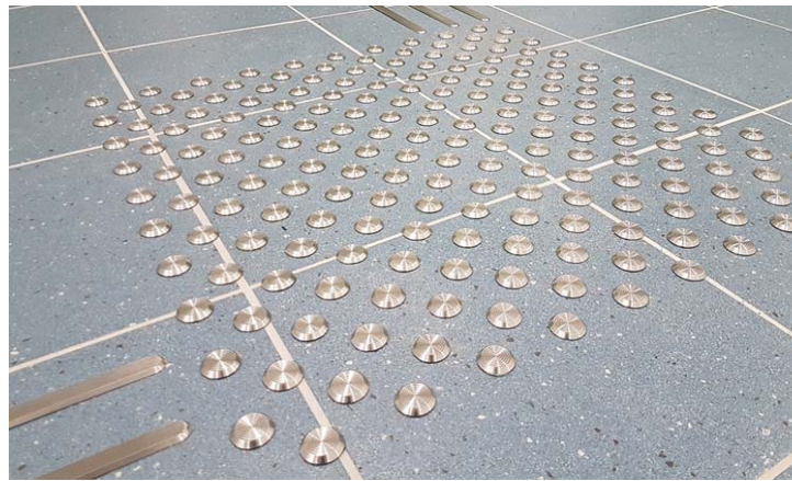
Bild 8: Taktile Bodenindikatoren aus Edelstahl Rostfrei in Form von Aufmerksamkeitsfeldern aus Noppen oder Leitstreifen aus nichtrostendem Stahl sind vom Gesetzgeber vorgeschriebene Orientierungshilfen für öffentlich zugängliche Gebäude.
