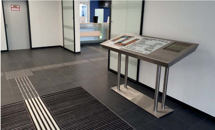
Bild 5: Taktile Bodenindikatoren aus Edelstahl Rostfrei bieten als in Laufrichtung verlegte Leitstreifen oder Aufmerksamkeitsfelder vor Infotafeln wertvolle Orientierung.
