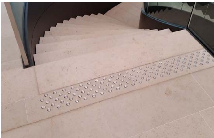
Bild 9: Rutschfeste Edelstahlrippen und -noppes werden als sogenannte Aufmerksamkeitsfelder in Bereichen verlegt, die besondere Beachtung erfordern wie hier an einer Treppe.
