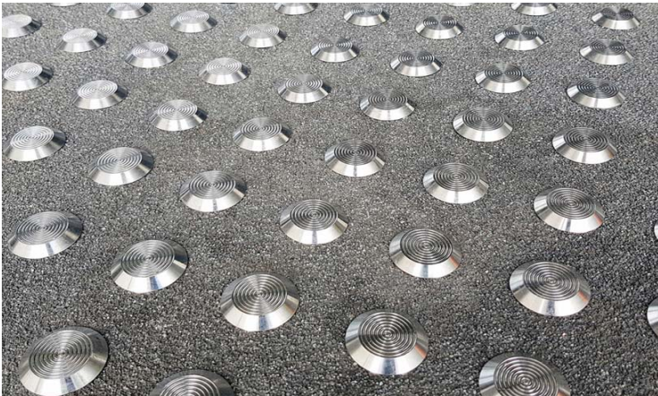
Bild 7: Im Innen- wie Außenbereich vereinen taktile Bodenindikatoren aus Edelstahl Rostfrei stilvolles Design und Robustheit.
