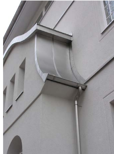
Bild 3: Dacheindeckung mit Edelstahl Rostfrei bei einer Stadtvilla in Berlin
