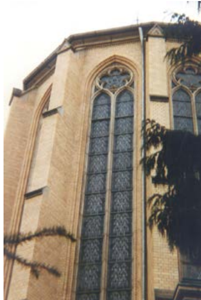
Bild 2: Dachentwässerung aus verzinnemtem Edelstahl Rostfrei an einer denkmalgeschützten Kirche
