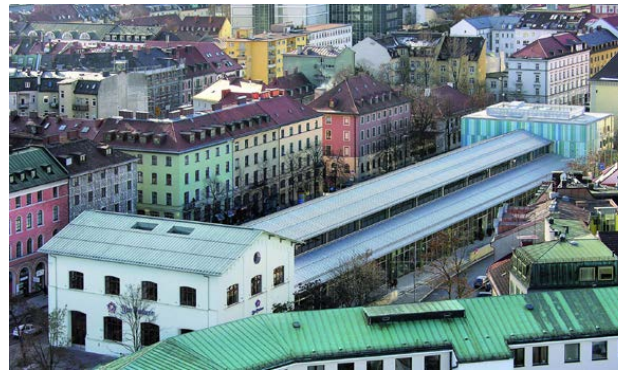
Bild 5: Die Schrammenhalle in München fügt sich mit einem Dach aus verzinnemtem Edelstahl Rostfrei in das Bild der umliegenden Kupferdächer
