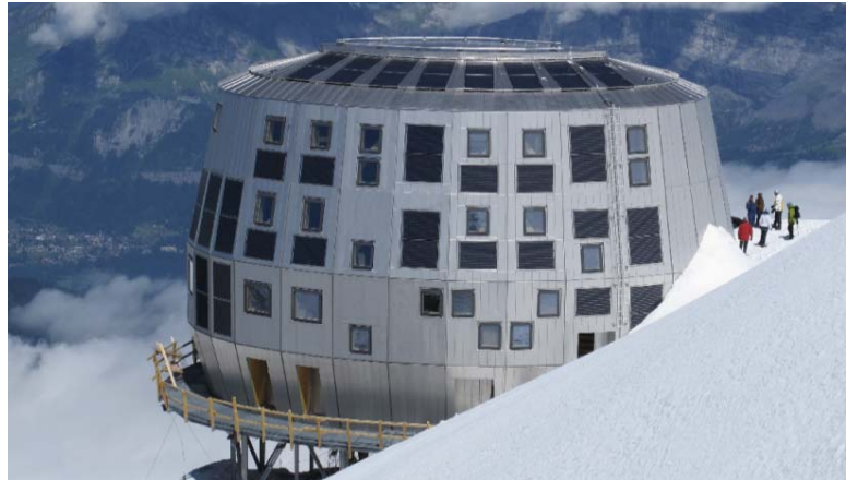
Bild 2: Unempfindlich gegenüber UV-Strahlung und korrosionsbeständig bewährt sich die Edelstalhülle der Refuge du Goûter als nachhaltig wirtschaftliche Entscheidung.
