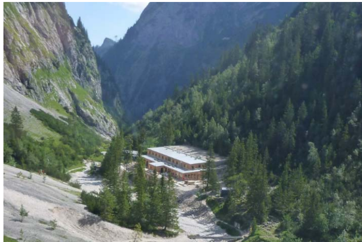
Bild 3-4: Auf die wärmegegedämmte hinterlüftete Holzunterkonstruktion des Dachs der Höllentalangerhütte im Wettersteingebirge wurde eine 600 Quadratmeter große Doppelstehfalzdeckung aus Edelstahl Rostfrei aufgebracht.
