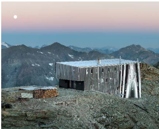
Bild 7: Drei Fassadenseiten und das Dach der Tracuit-Hütte in den Walliser Alpen sind mit hochglänzendem Edelstahl verkleidet.
