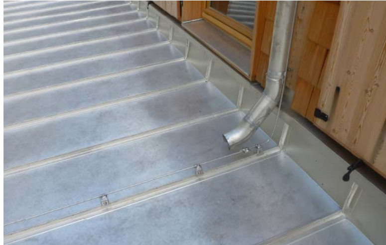
Bild 3-4: Auf die wärmegegedämmte hinterlüftete Holzunterkonstruktion des Dachs der Höllentalangerhütte im Wettersteingebirge wurde eine 600 Quadratmeter große Doppelstehfalzdeckung aus Edelstahl Rostfrei aufgebracht.
