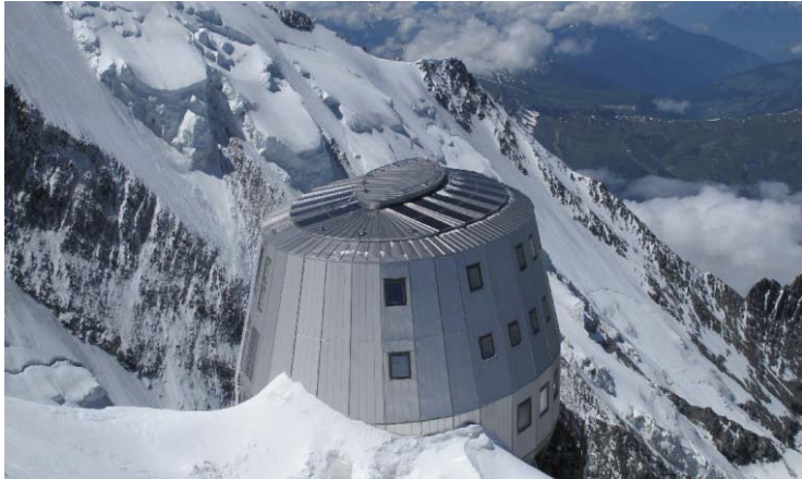
Bild 1: Die am Mont Blanc neugebaute Refuge du Goûter erhielt eine glänzende Haut aus Edelstahl Rostfrei.
