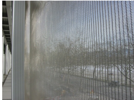
Bild 2: Edeltstahlgewebe verkleidet die Fassade des Stade de Suisse Wankdorf.
