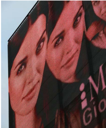
Bild 1: MEDIAmesh als Projektionsfläche für Werbung oder Live-Übertragungen.
