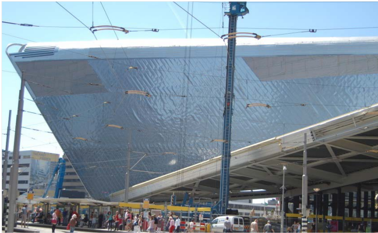
Bild 6: Pfeilförmig aufragende Dach-Fassadenkonstruktion aus Edelstahl Rostfrei mit Qualitätssiegel am Hauptbahnhof Rotterdam.
