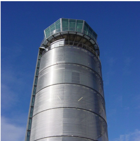
Bild 8: Der Kontrollturm des Flughafen Barajas in Madrid verfügt über eine gewebte Haut aus nichtrostendem Stahl.
