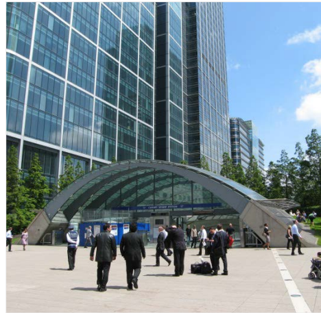
Bild 2: Norman Fosters Baldachin aus Glas und Edelstahl an der U-Bahn-Station Canary Wharf hält dem aggressiven Flussklima an der Themse stand.
