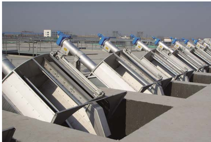
Bild 6: Feinstrechen aus Edelstahl Rostfrei garantieren eine zuverlässige Feststoffabscheidung in der mechanischen Reinigung.
