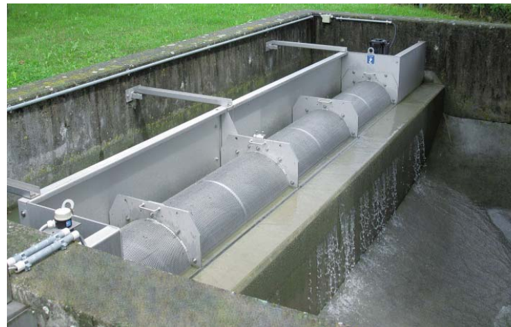
Bild 4: Siebanlagen aus Edelstahl Rostfrei sorgen auch bei großen Durchflussmengen für optimalen Feststoffrückhalt in Regen- und Regenüberlaufbecken.
