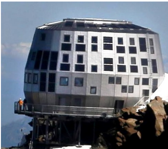
Bild 3: Der traditionelle Holzbau erhielt eine witterungsbeständige Hülle aus Edelmantel Rostfrei.
