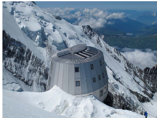
Bild 4: Futuristisches Aussehen durch eine vollflächige Verkleidung mit Planken aus Edelmantel Rostfrei
