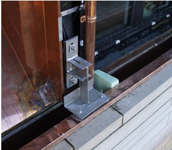
Bild 5: Schraubenverbindungen mit Tragankern aus Lean Duplex Edelstahl befestigen Baupfeiler an Fassaden.
