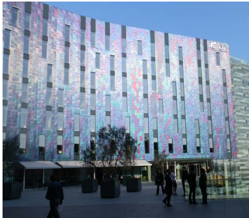
Bild 5: 4.500 Quadratmeter Edelstahl kreieren den beeindruckenden Farbeffekt dieser auffälligen Gebäudehülle. Hotel Aloft, London
