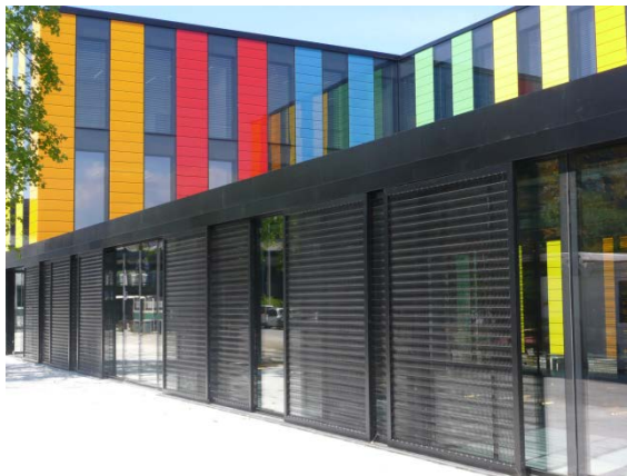
Bild 7: Schwarz lackiertes Edstahlgewebe setzt farbige Structural Glazing-Fassaden in Szene. Verwaltungs- und Servicezentrum der EPFL, Lausanne
