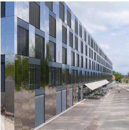
Bild 3: Neue dreidimensionale Verformungstechniken erweitern kreative Spielräume moderner Fassadengestaltung. Géopolis / Geo- und Umweltwissenschaftliche Fakultät, Lausanne
