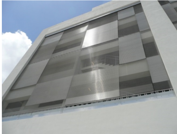
Bild 2: Die in unterschiedlicher Materialdichte schimmernde Haut aus Edeltstahlgewebe verleiht dem Parkhaus eine unverwechselbare Schachbrettoptik. Parkhaus Doral Park, Florida
