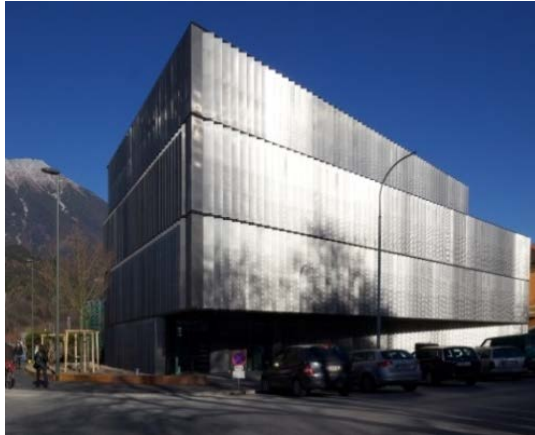
Bild 1: Gebäudehüllen mit Lamellen aus Edeltstahlgewebe verbessern ganzjährig das Raumklima. ASFINAG Bürokomplex, Innsbruck
