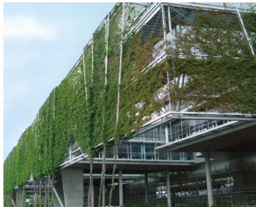
Bild 8: Seilsysteme mit Rankseilen aus rostfreiem Edelstahl geben hier Pflanzen dekorativen Halt.
