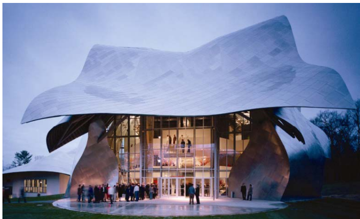
Bild 10: Auch für die dynamische Dachoberfläche des Richard B. Fisher Centers setzte Gehry auf Edelstahl Rostfrei.
