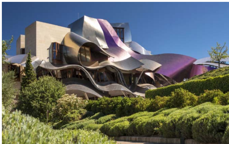
Bild 8: Metallbänder – unter anderem aus Edelstahl Rostfrei – formen den opulenten Kopfschmuck des Hotels Marqués de Riscal .
