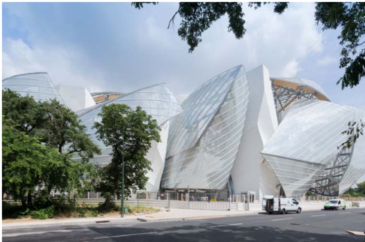
Bild 16-18: Für die Dachkonstruktion der Fondation Louis Vuitton setzte Gehry im großen Umfang Duplex Edelstahl 2205 ein.
