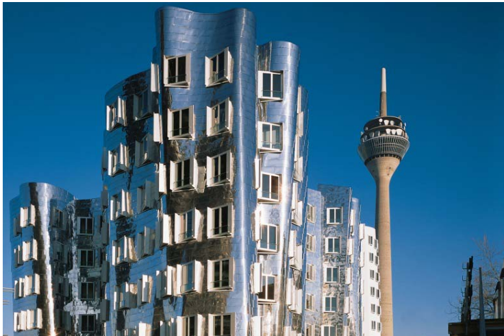
Bild 3: Für das markante Gesicht des mittleren Turms des Neuen Zollhofs in Düsseldorf wurden 4.700 Quadratmeter Edelstahlblech verwendet.
