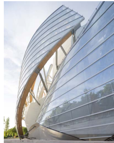
Bild 16-18: Für die Dachkonstruktion der Fondation Louis Vuitton setzte Gehry im großen Umfang Duplex Edelstahl 2205 ein.
