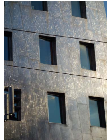
Bild 4-5: Der Gehry Tower in Hannover besteht aus 2.800 handgeschliffenen Edelstahlblechen.
