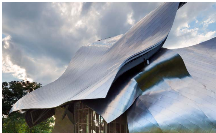
Bild 11: Wie Tücher bilden 5.647 Schindeln aus Edelstahl Rostfrei das mehrteilige Dach des Richard B. Fisher Centers .
