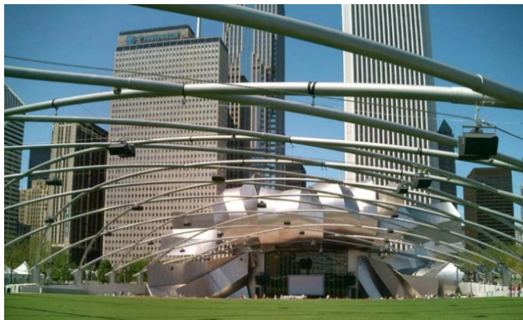
Bild 9: Breite, spiralförmig aufspringende Bänder aus Edelstahl Rostfrei bilden die skulpturale Bühnenüberdachung des Jay Pritzker Pavillons .
