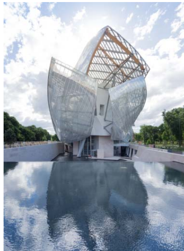
Bild 16-18: Für die Dachkonstruktion der Fondation Louis Vuitton setzte Gehry im großen Umfang Duplex Edelstahl 2205 ein.
