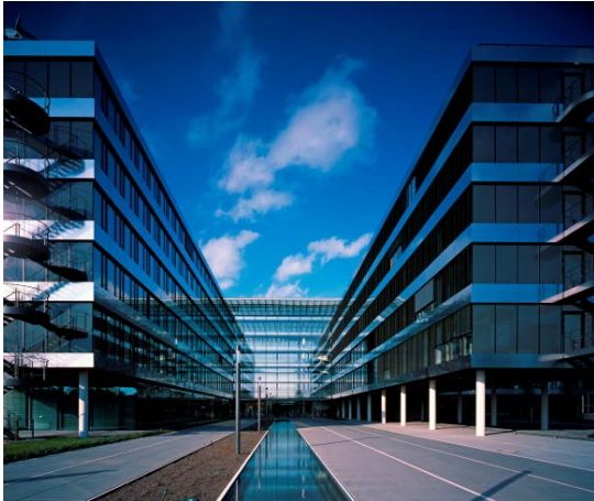
Bild 5-6: Bei der Fassadenkonstruktion der HDI Gerling Konzernzentrale in Hannover wurden Edelstahlbleche auf eine Trägerkassette aus Aluminium verklebt und an der Unterkonstruktion befestigt.
