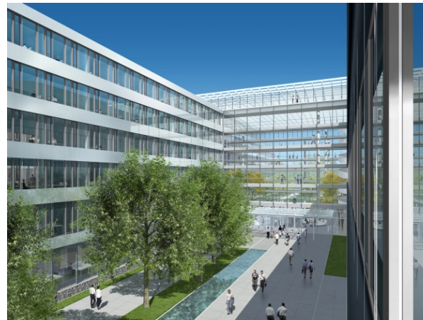
Bild 4: Bei der Fassadenkonstruktion der HDI Gerling Konzernzentrale in Hannover wurden Edelstahlbleche auf eine Trägerkassette aus Aluminium verklebt und an der Unterkonstruktion befestigt.
