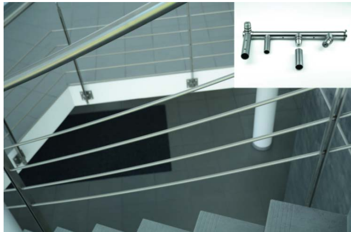
Bild 3: Verklebung von Systemelementen aus Edelstahl Rostfrei im Geländerbau. Zuschnitte sowie Schweißarbeiten entfallen durch Verwendung von Klebstoffen.
