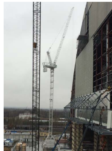
Bild 3-4: Für die Gestaltung der Außen- und Innenschale des NSC wurden 1.200 Tonnen Edelstahl Rostfrei mit Qualitätssiegel eingesetzt. So soll die Schutzhülle für rund 100 Jahre verhindern, dass Regen oder Schnee eindringen und zuverlässigen Schutz gegen radioaktive Emissionen bieten.
