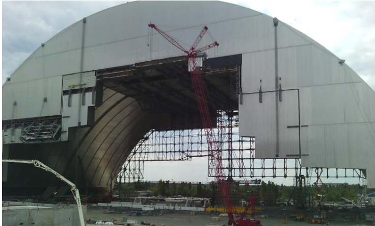
Bild 5: Spezialkrane, die schienengeführt bis zu 50 Tonnen schwere Lasten heben können, sollen in den kommenden Jahrzehnten den unter dieser Schutzhülle verborgenen Inhalt ferngesteuert zerlegen und entsorgen.
